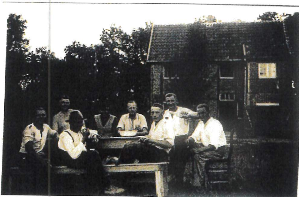
Abbildung 7 Arbeiter des benachbarten Steinbruchs (Archiv Thier)
